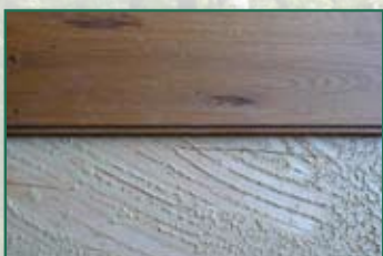
Vollflächiges Verkleben auf Estrich
