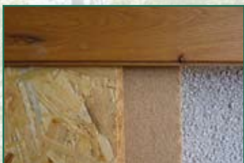
Verschraubung auf OSB-Platten, Naturdämmplatten und Schüttungen
