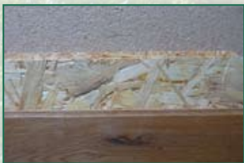
Verschraubung auf OSB-Platten und Naturdämmplatten
