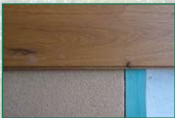
Verschraubung auf Lagerhölzer mit Holzfaserdämmplatten
